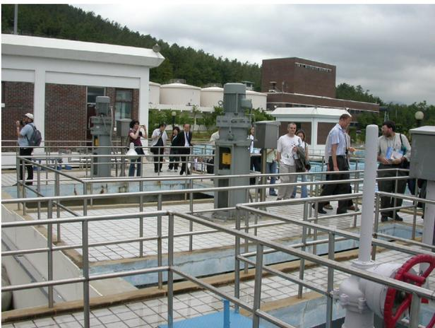
その次は沈澱池とろ過池に行ったが、沈殿池にはスカムも無く、ろ過池の水はかなり透明度が高く、凝集沈澱処理がかなりうまくいっているように見えた。
