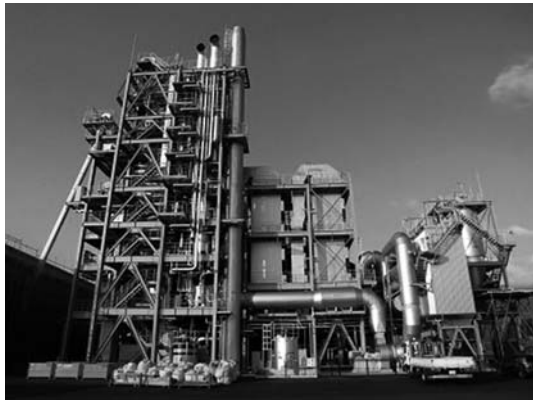
Photo 1 木質バイオマス発電所全景
