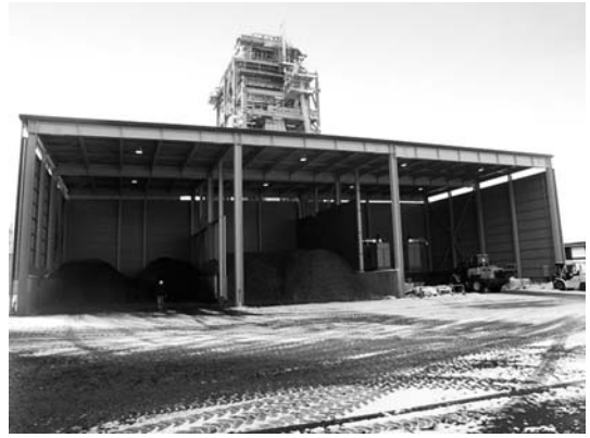
Photo 2 チップ貯留ヤード
