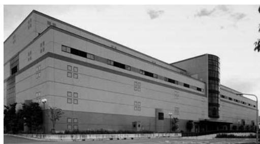
村野浄水場 高度浄水処理施設
