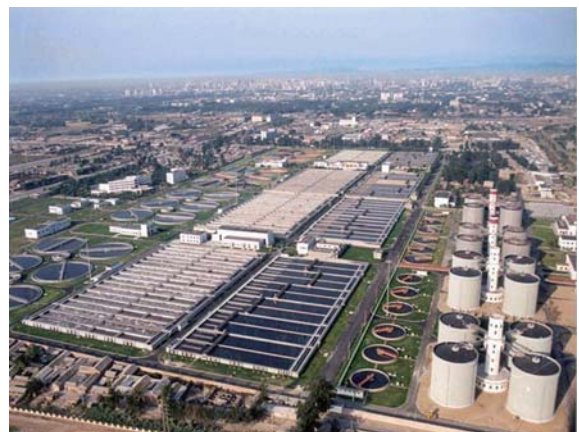
写真1 北京市高碑店污水处理場（写真提供：北京排水集団）
