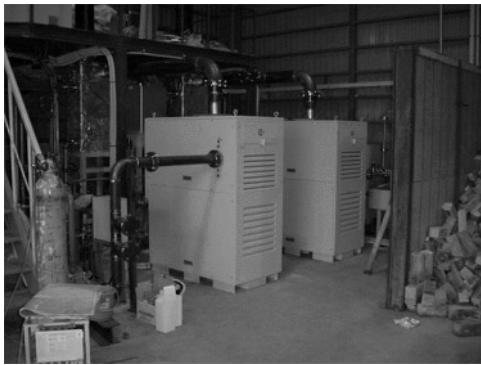
Fig.19 木タールと木ガスを使った Micro-Gas-Turbine
